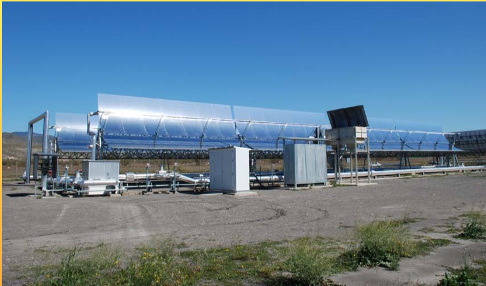
Vista general de la planta
