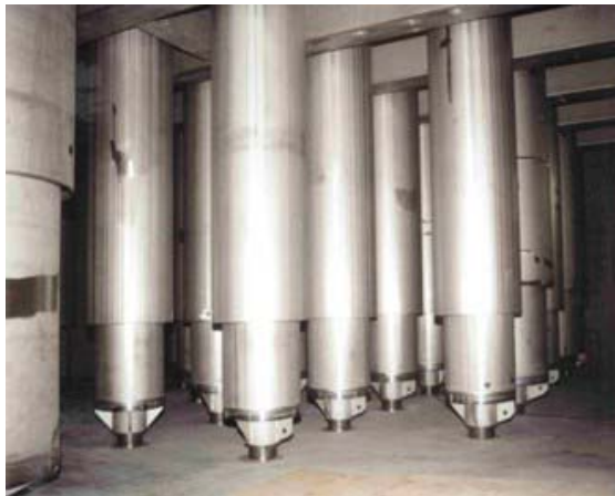
VISTA INFERIOR DE LA BÓVEDA
