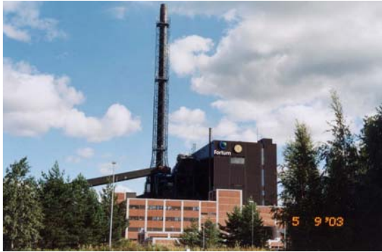
Planta CHP multicombustible de biomasa en Rahualati (Finlandia).30 MW
