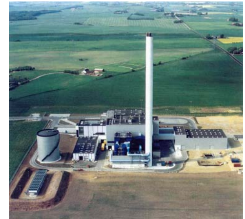
Planta CHP multicombustible de biomasa en Mabjergvaerket (Dinamarca).28 MW.
