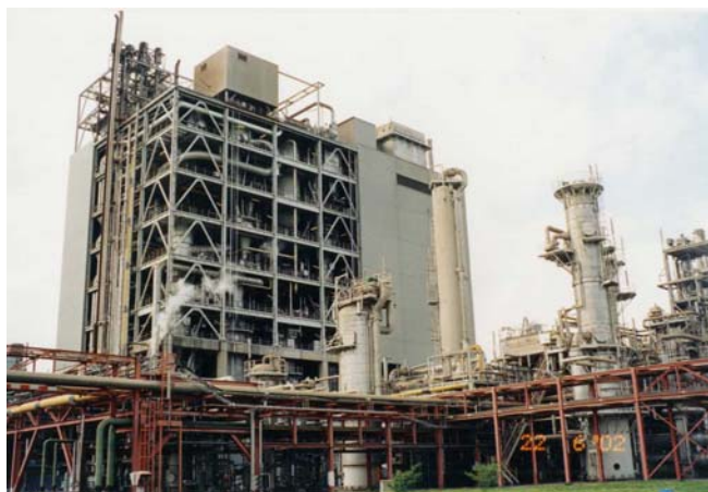
BUGGENUM. IGCC carbón-biomasa. 250 MWe.
