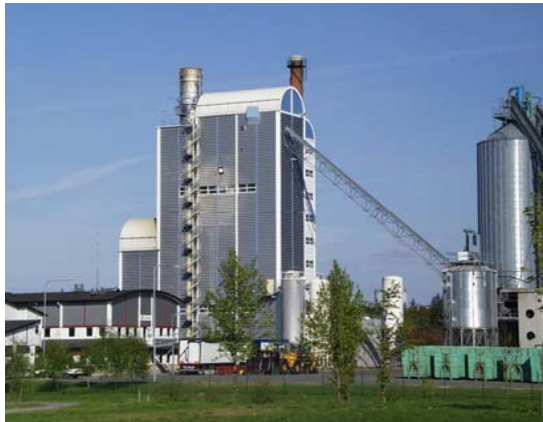
Planta de Värnamo. BIGCC (gasificación a presión) 8,7MWe
